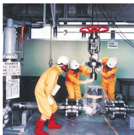
主動弁分解点検訓練（原子力研修センター内）
