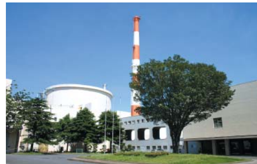
高速実験炉「常陽」 茨城県大洗町－熱出力14万kW（発電設備はありません）
