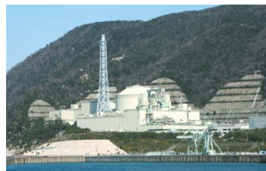
高速増殖原型炉「もんじゅ」 福島県敦賀市－熱出力71.4万kW・電気出力28万kW
