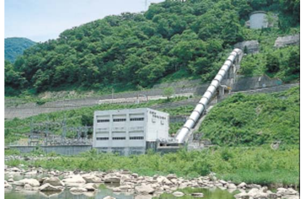
西勝原第三発電所(昭和43年運転開始)
