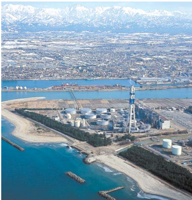
北陸初の大容量石油火力、富山火力発電所 (昭和39年運転開始)
