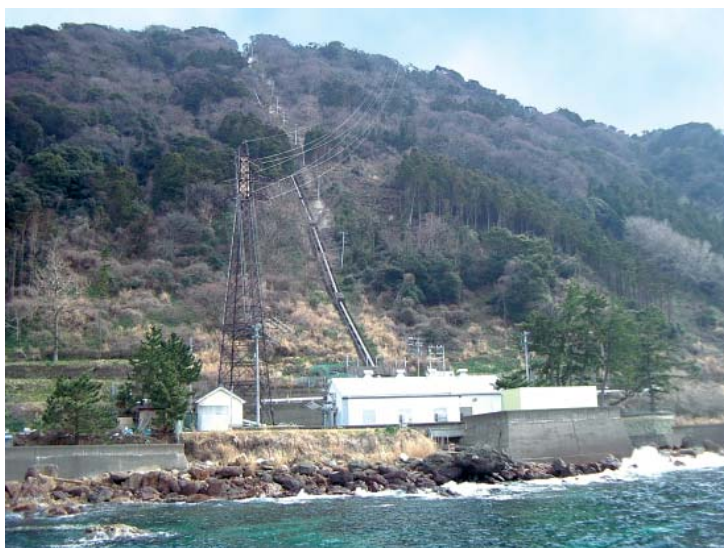
蒲生発電所（県内初のダム水路式 大正9年運転開始）
